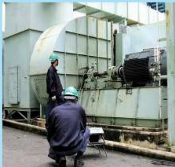
ใบพัดขนาดเส้นผ่าศูนย์กลาง 2000 mm. 1450 rpm. Power 550 Hp
